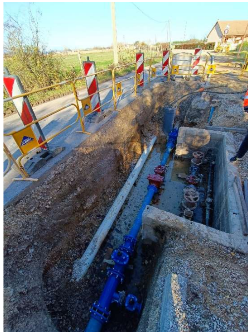
Travaux à Fragnes la Loyère, rue du bourg
